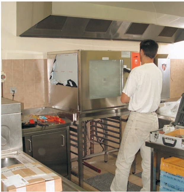
"installation du nouveau four"
