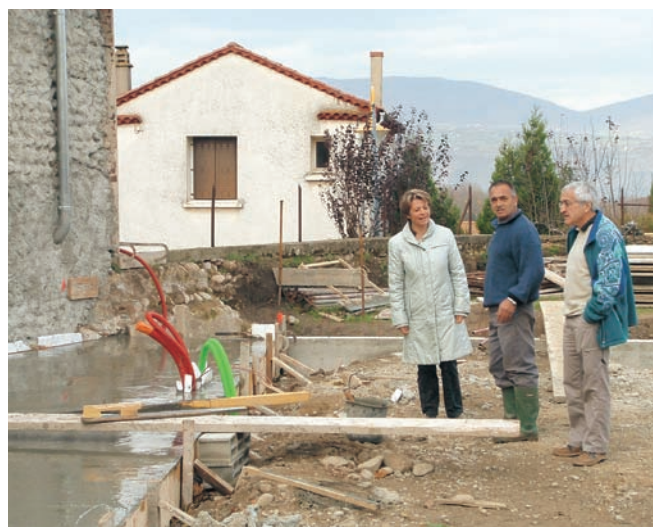
« Sur le site avec le chef de chantier »
