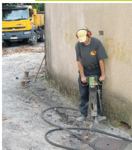
"réfection voirie et caniveaux"
