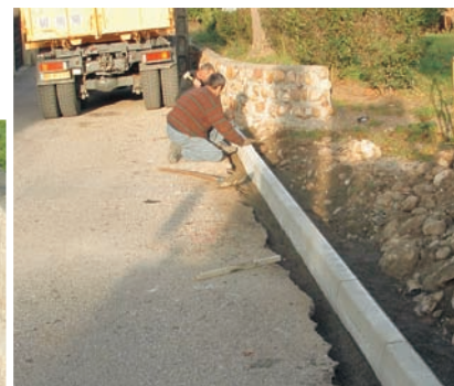
"pose de bordures"
