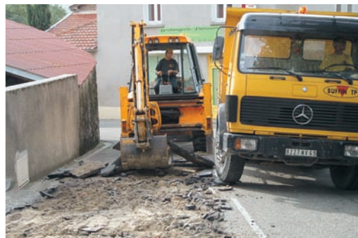
"réfection voirie et caniveaux"
