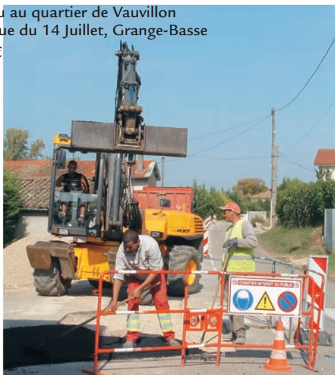
Extension du réseau d'assainissement
