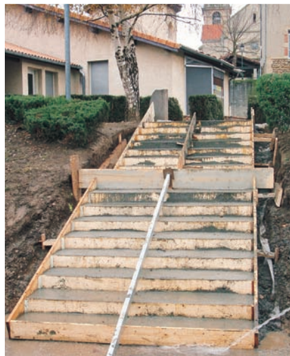
A l'école : reprise de l'escalier en maçonnerie
