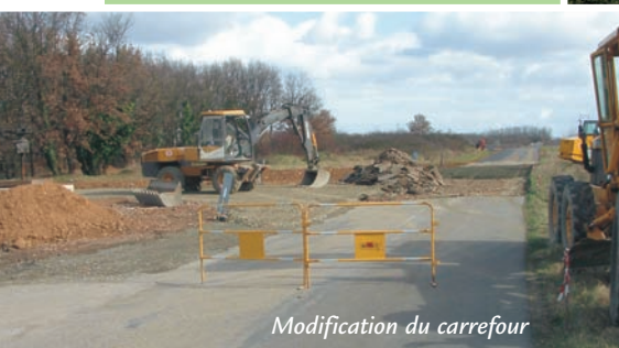
Reprise de l'enrobé jusqu'à l'entrée du bourg
