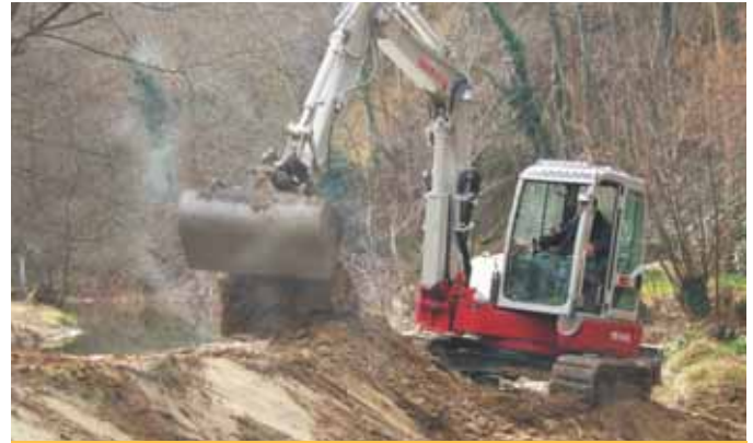
Desablage de la partie amont du canal.
