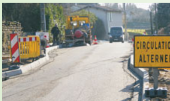
Création d'un rétrécissement pour circulation alternée
