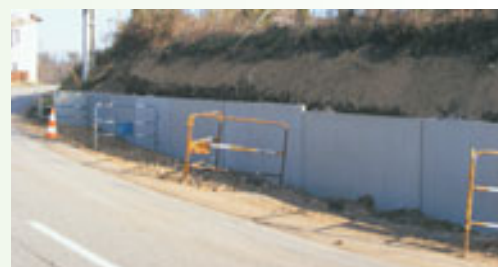
Mur de soutènement
