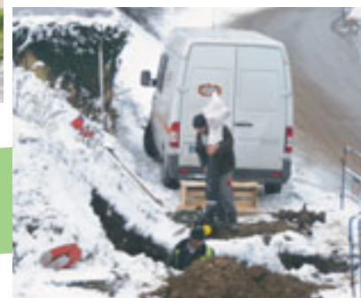
Route d'Auberives : remplacement d'une borne incendie
