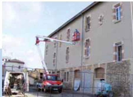
Début des travaux
