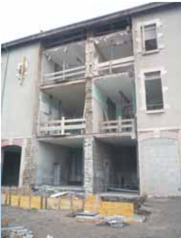
Ouverture de la façade ouest
