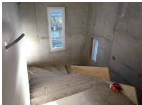
Intérieur : escalier central
